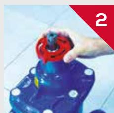
Acople la base del dispositivo a la válvula.
