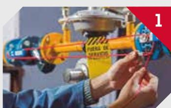
Pase el cable por los elementos que va a asegurar.
