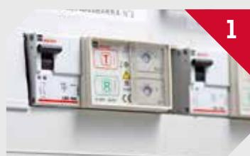
Comprobar si el interruptor está encendido o apagado previamente a colocar el bloqueo.
