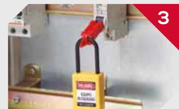
Inmovilice el dispositivo colocando un candado en el orificio del pulsador.
