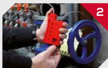
Presione el portacandados para poder introducir el cable y tensarlo. (Se recomienda señalizar la zona con una etiqueta. Pásela por el cable antes de introducir éste en el portacandados).
