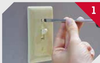
Retire los tornillos del enchufe usando un destornillador.
