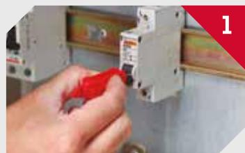
Asegúrese de que el interruptor está apagado antes de colocar el bloqueo y luego colóquelo en posición.
