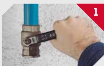
Antes de introducir el bloqueo en la llave de paso, compruebe si la válvula tiene el paso cerrado.
