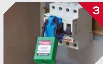
Coloque un candado como elemento de bloqueo y señalización del dispositivo.
