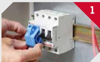
Coloque el bloqueo en posición sobre el interruptor.
