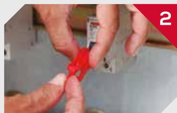
Presionar el pulsador (imagen superior) o empuje el tirador hacia el interruptor (imagen inferior) para ajustar los pasadores al interruptor.
