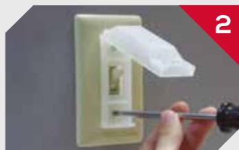
Presente el dispositivo de bloqueo sobre el interruptor, alineándolo con sus agujeros para los tornillos. Atornille el bloqueo al interruptor.
