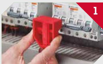
Antes de colocar el dispositivo, compruebe que el interruptor está apagado.
